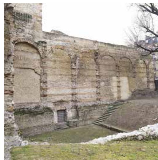
1 Mur de la palestra
