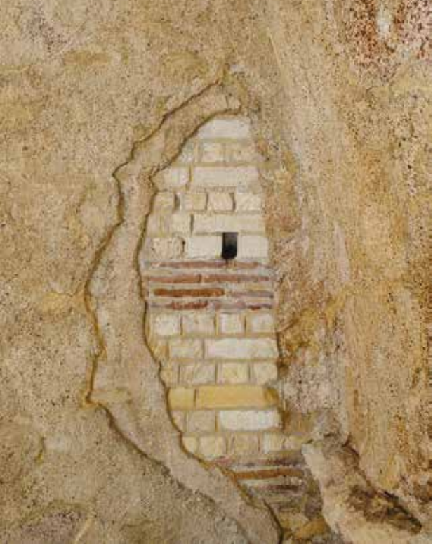
5 Superposition des couches d'enduits
