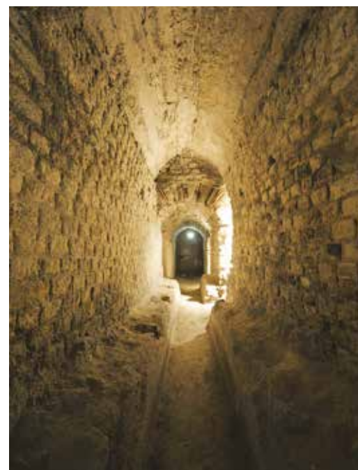
3 Sous-sols techniques : canal d'évacuation
